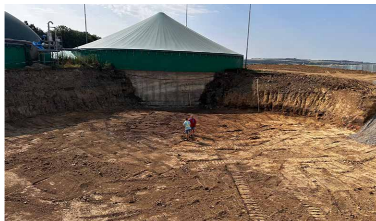
► Rekonstrukce bioplynové stanice
