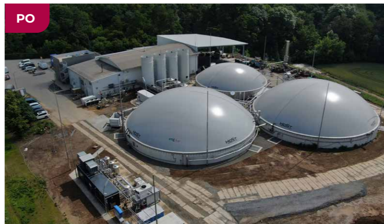
► Instalace nových fermentorů
